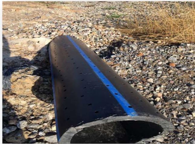
Őekil 2. Sızıntı Suyu Drenaj Sistemi
